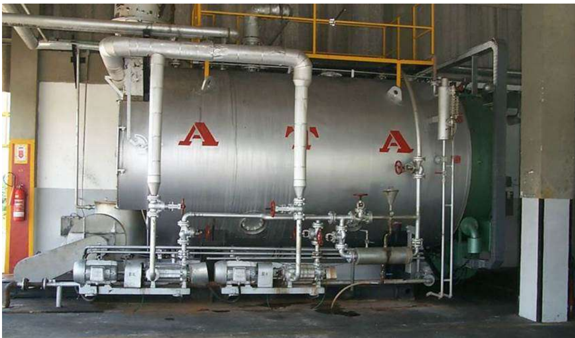
Figura 16 - Vista lateral oposta da caldeira.
