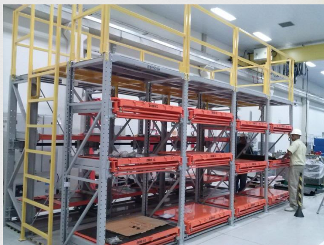
Prateleira com proteção - escada de acesso e guarda corpo
